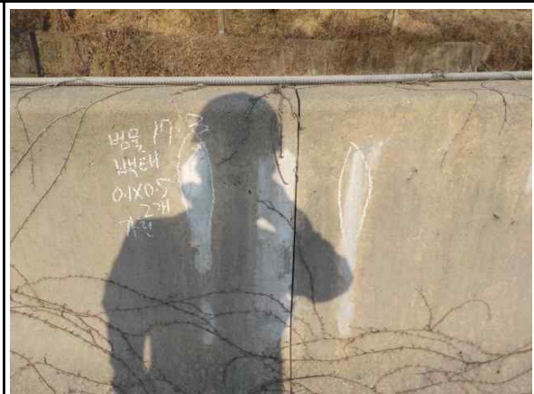
위 치 콘크리트방호벽(범물)
