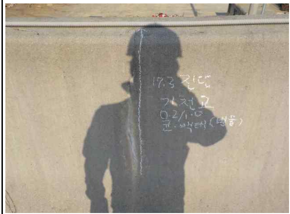
위 치 콘크리트방호벽(범물)
