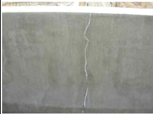
위 치 콘크리트방호벽(안심)
